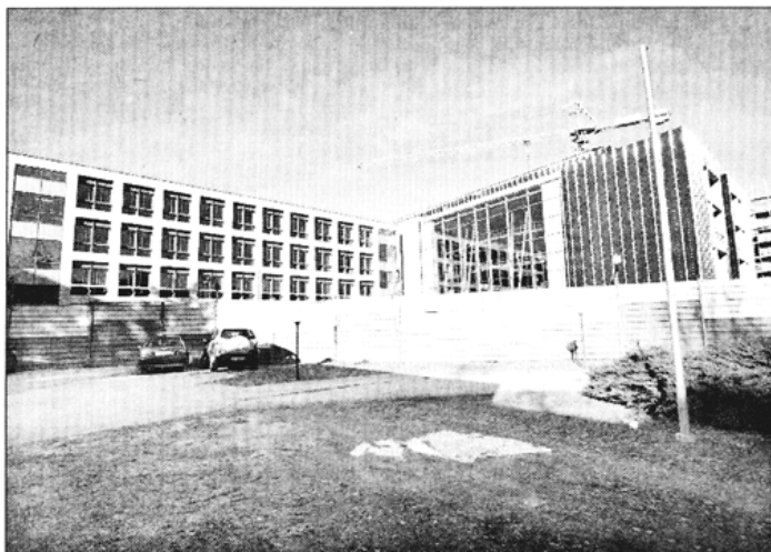
Il cantiere del nuovo ospedale di Udine
