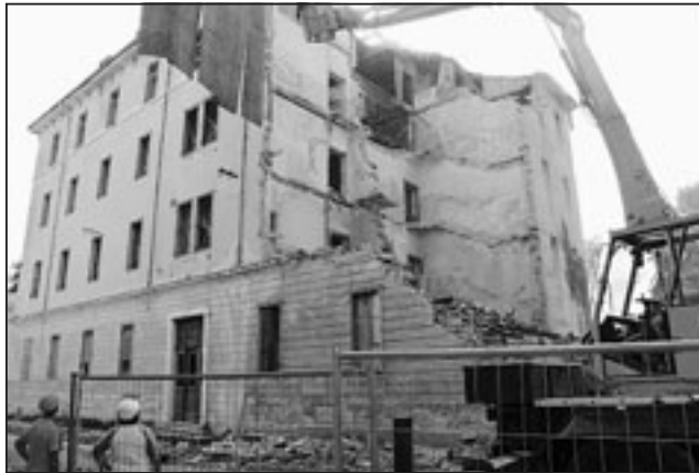
Le operazioni di abbattimento dell'ex scuola Locchi in via Margotti
