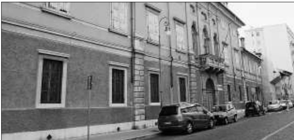
Da settembre partono i lavori per il complesso dell'ex Toppo Wassermann
