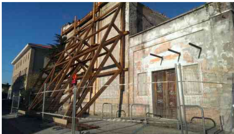
Il reticolato di travi in legno che sostiene il vecchio cinema
