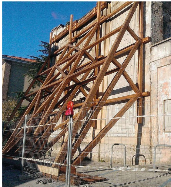
Sopra il reticolato di travi in legno che sostiene il vecchio cinema. Sotto, due immagini di degrado del compendio della Stella Matutina
