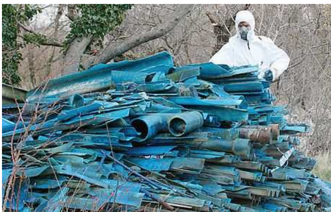
Bonifica di Eternit, materiale con amianto, sul Carso (foto Lasorte)
