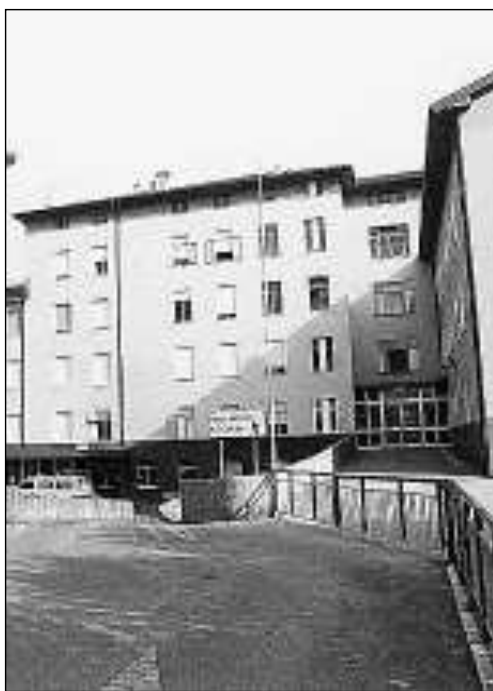
L'ospedale di Cividale: ultimati i lavori al pronto soccorso
