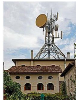
L'impianto di vicolo Amalteo
