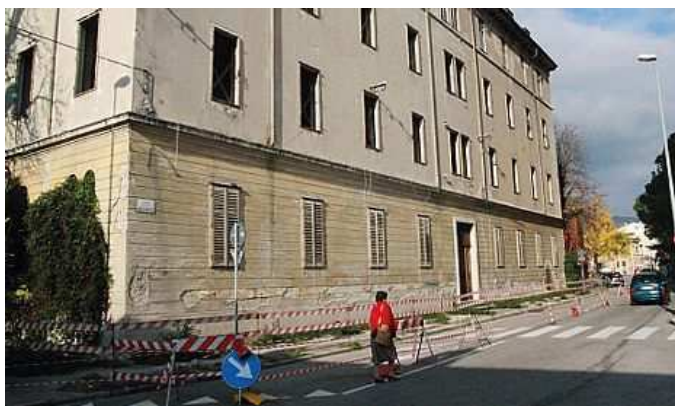
L'edificio di via Margotti prima della demolizione
