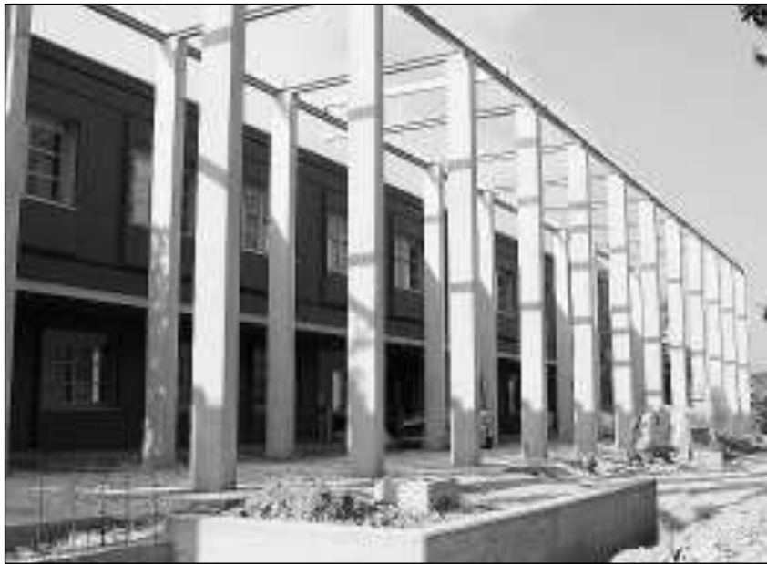
La nuova facciata del Consorzio universitario di via Prasecco con le colonne di cemento
