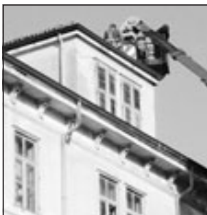
Sopralluogo al tetto dell'ex Locchi
