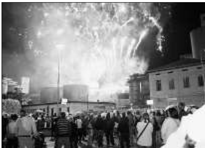
Con la demolizione della ciminiera si è iniziata la fase decisiva del progetto
