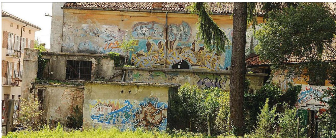
La palazzina che ospitava il cinema nel complesso della Stella Matutina: il degrado e le scritte con lo spray dei graffitari la fanno da padroni indiscussi
