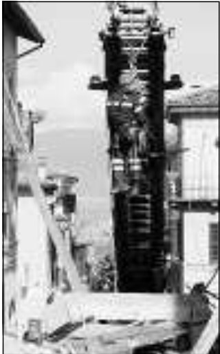
Gli ingegneri dell'ateneo udinese monitorano gli edifici pericolanti
