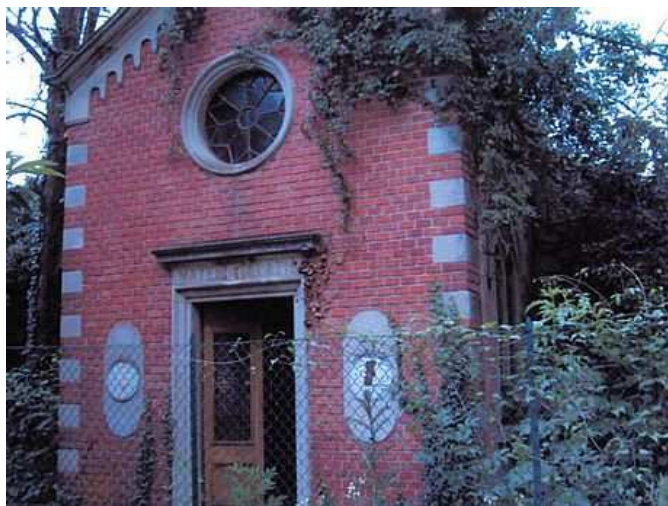
La chiesetta del Renati, destinata alla demolizione
