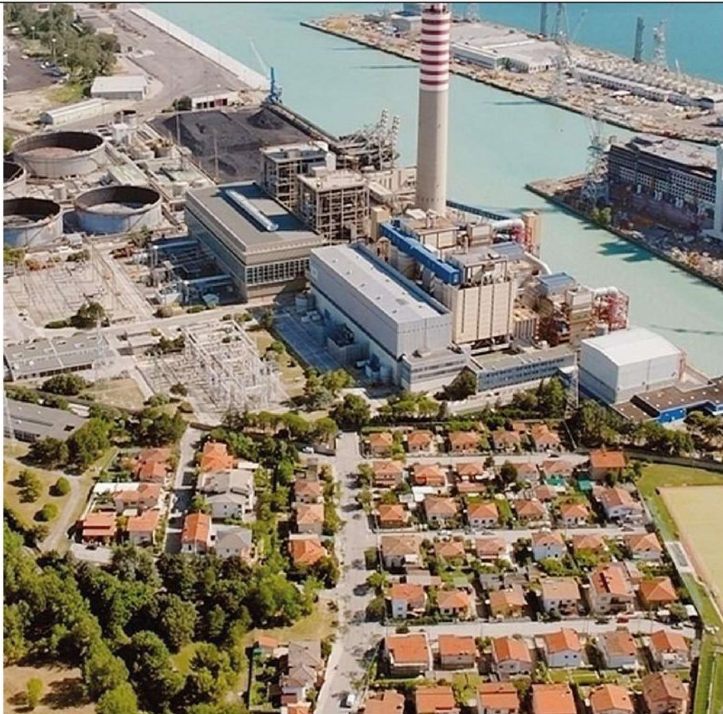
La centrale termoelettrica di A2A con ai piedi le case del rione Enel
