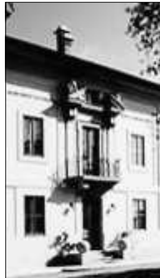
La sede dell'acquedotto Poiana di Cividale
