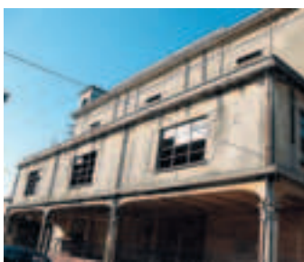
FUTURA SEDE. L'ex frigo
