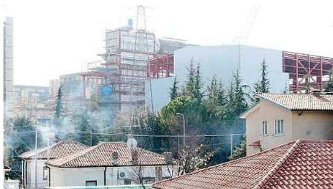
La centrale termoelettrica di A2A a Monfalcone
