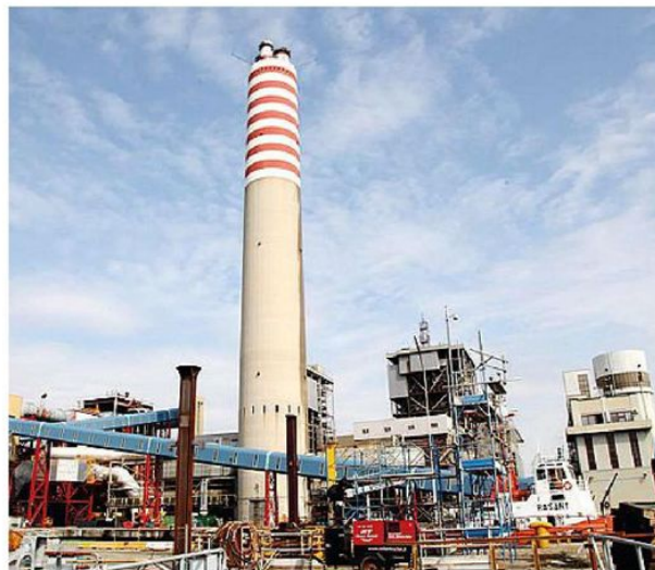
La centrale elettrica di Monfalcone
