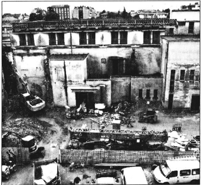
Una panoramica del cantiere alle Grazie
