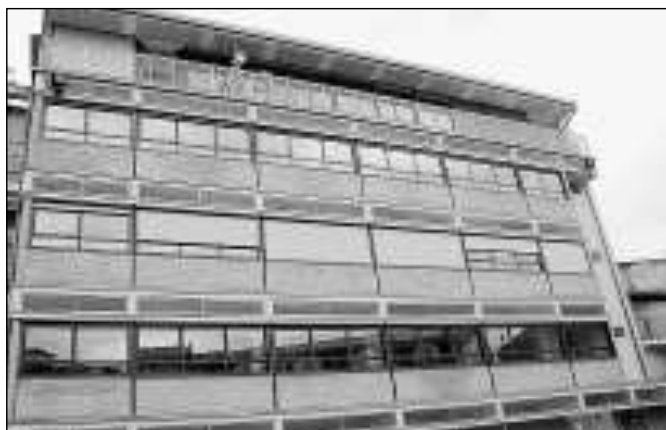
L'esterno dell'edificio che ospita i nuovi alloggi realizzati per gli studenti
