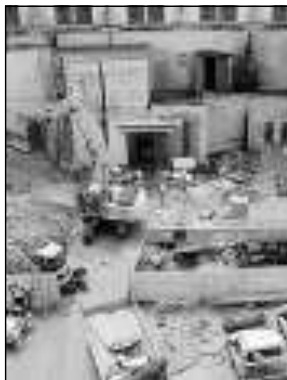
Il cantiere esterno
