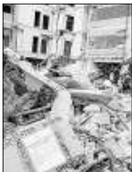
Edificio distrutto all'Aquila Comune dell'Aquila
