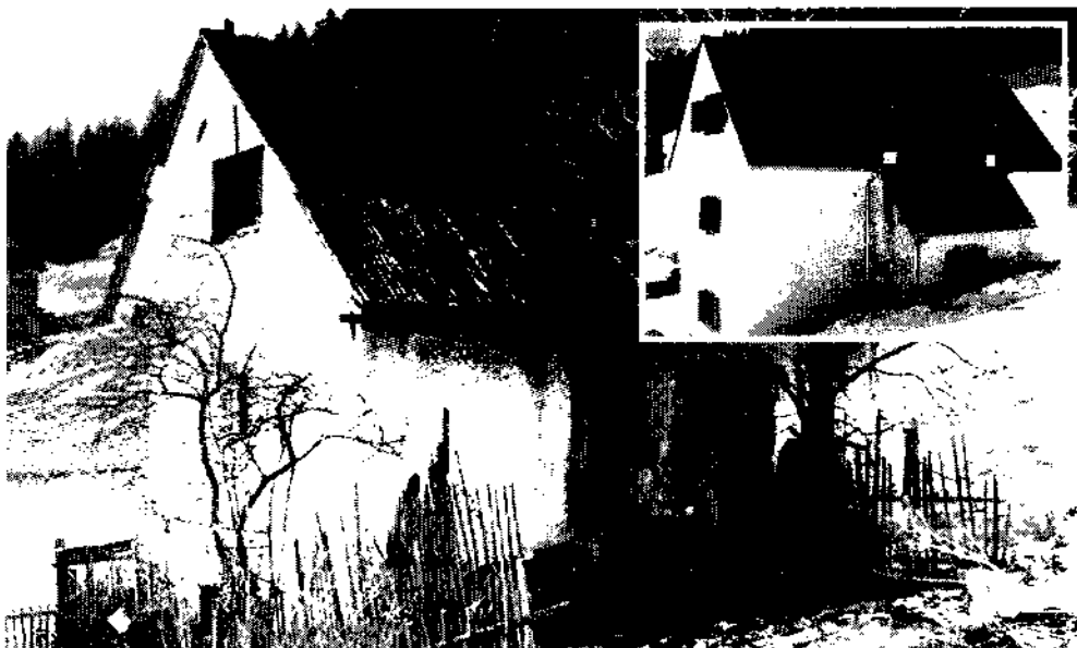
Nella foto: immobile nel Comune di Forni Avoltri. Nel riquadro: lo stesso dopo la sua ristrutturazione.
