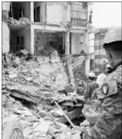
Il centro dell'Aquila è un ammasso di macerie, qui gli universitari verificheranno la stabilità delle scuole
