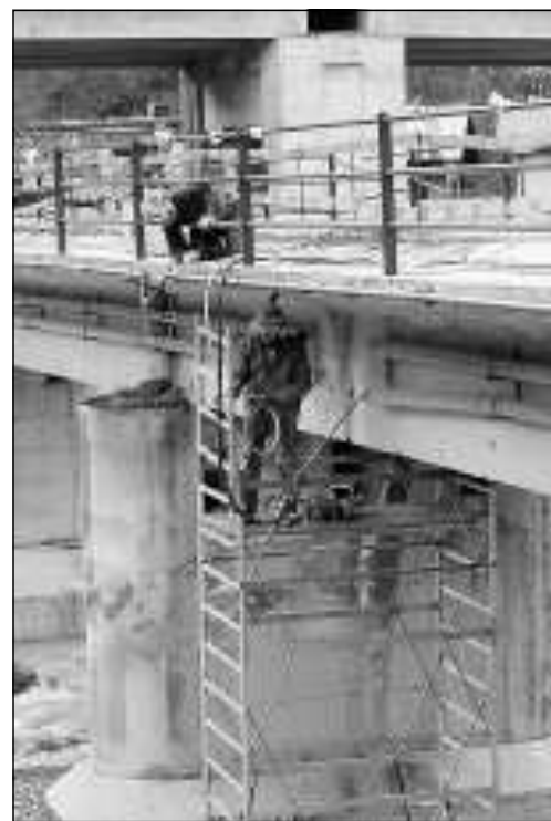
Alcuni operai installano i rilevatori sul ponte
