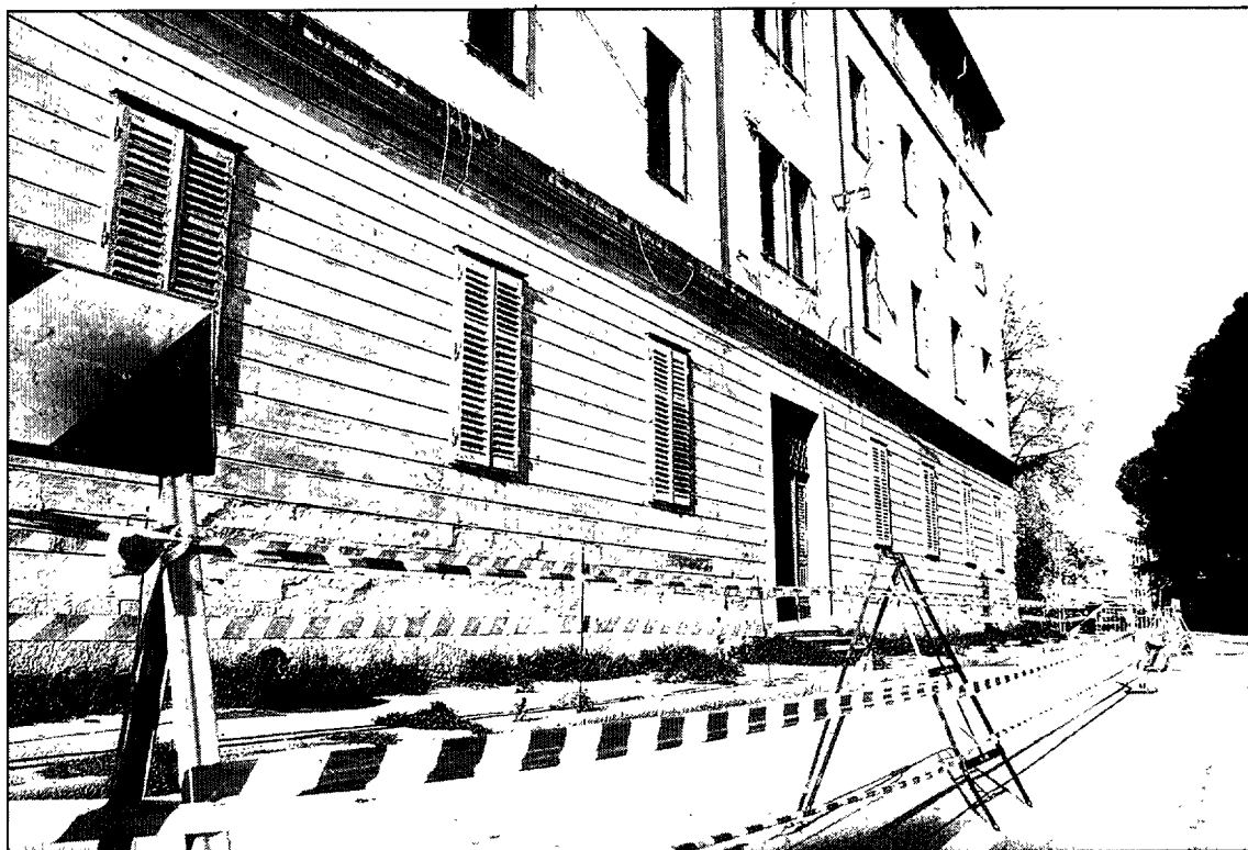
Il malconcio edificio dell'ex scuola Locchi che incombe su via Margotti
