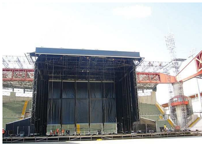
Lavori quasi conclusi allo Stadio Rocco, dove l'allestimento del megapalco è stato praticamente ultimato: si aspettano le ultime parti in arrivo oggi da Firenze, dove il tour ha fatto tappa ieri sera
