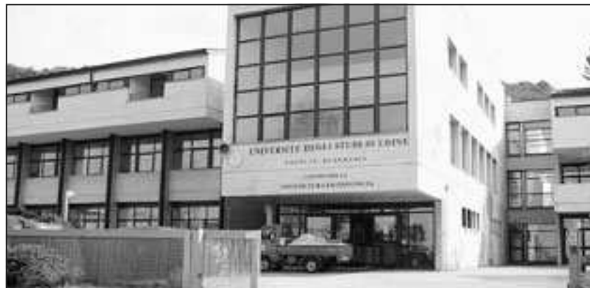
La sede dell'Università a Cormons: il futuro dell'edificio è incerto
