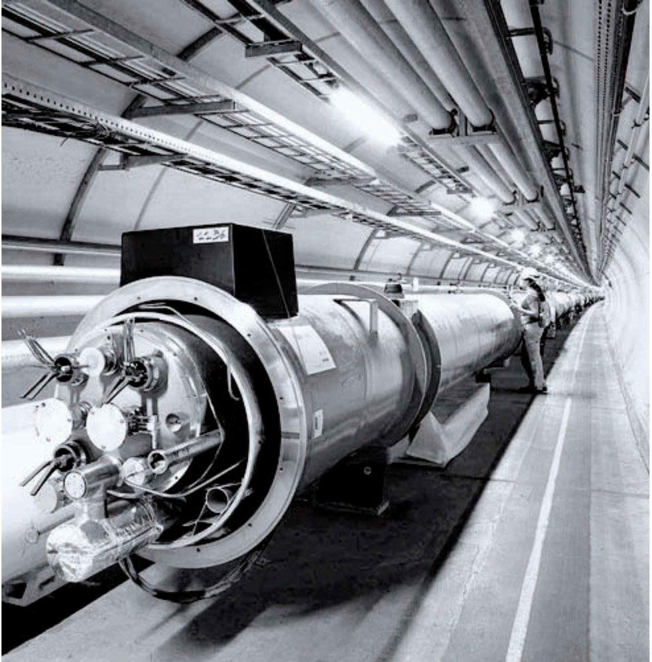
Un tratto dei 27 chilometri del tunnel ad anello, a cavallo tra Francia e Svizzera, dove si sviluppa l'acceleratore Lhc (foto Cern)
