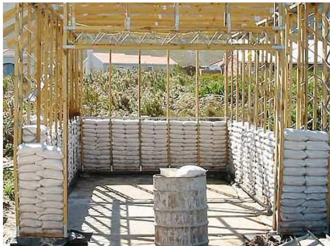
Una dimostrazione della realizzazione di una casa con sacchi di sabbia
