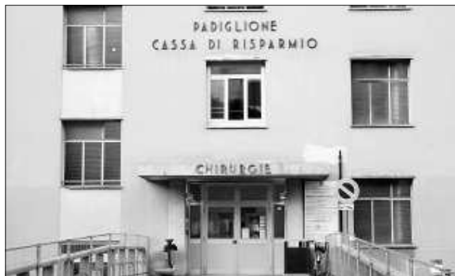
Il padiglione delle Chirurgie dell'ospedale: il reparto e la sala operatoria dell'Ortopedia si trovano al piano terra
