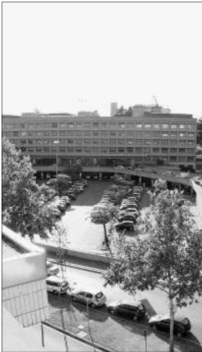
Teleriscaldamento in ospedale: assegnato l'appalto da oltre 80 milioni di euro per la realizzazione della centrale tecnologica: ha vinto un raggruppamento di quattro imprese
