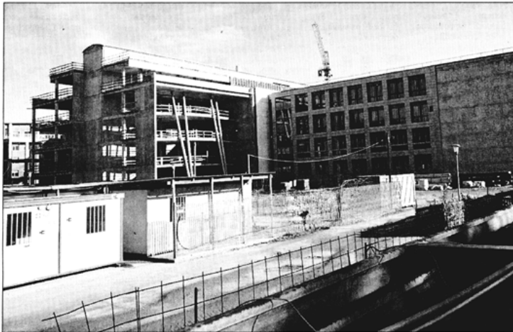
Il cantiere del nuovo ospedale di Udine: nei giorni scorsi si è dimessa la funzionaria responsabile del procedimento
