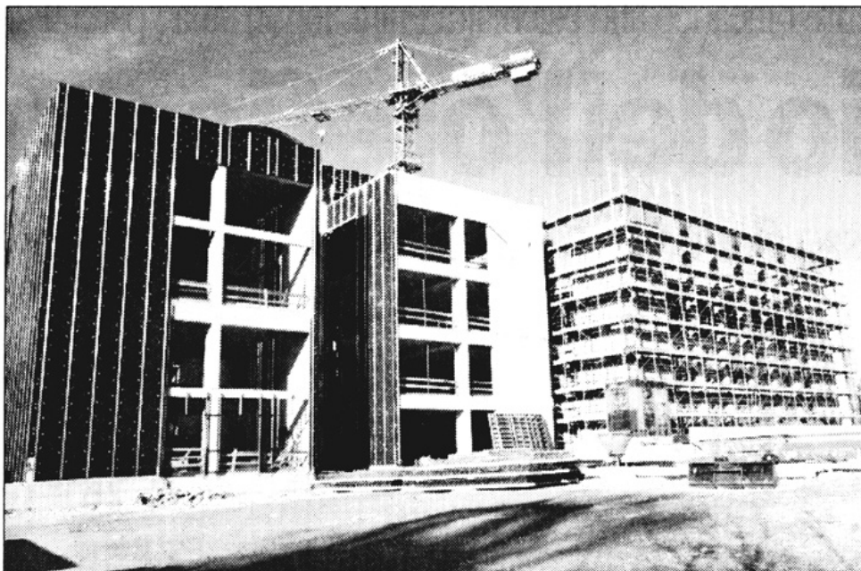
Il cantiere del nuovo ospedale di Udine: nei giorni scorsi si è dimessa la responsabile del procedimento
