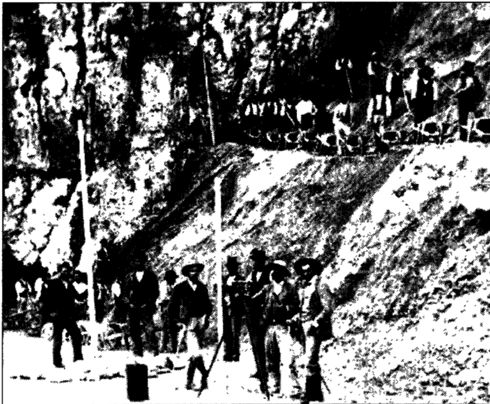
Lavori di sbancamento in Val Cellina per la costruzione di una delle vecchie centrali idroelettriche
