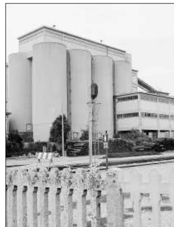
L'ex cementificio che sarà demolito per fare posto a "Cividale 2"
