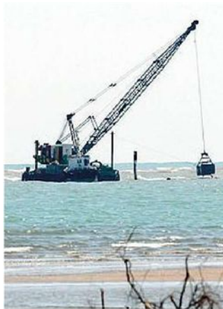
Una draga al lavoro in laguna
