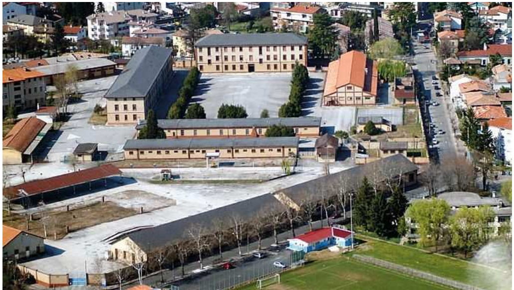
La caserma Amadio: entro la fine dell'anno si arriverà alla gara d'appalto per la demolizione degli edifici interni
