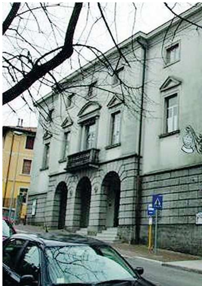
L'esterno del teatro Ciconi, che attende i lavori di ristrutturazione
