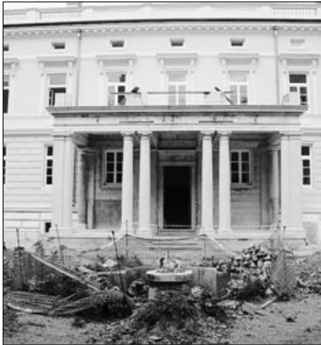
È iniziato nel 2005 il restauro di Villa Ritter
