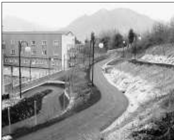
Conclusi i lavori per il percorso vita a Gemona
