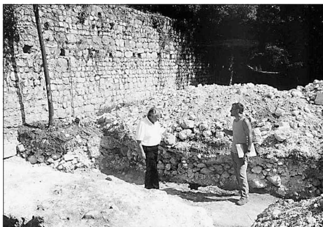
Lavori nell'area del castello a Tolmezzo. Il Comune dà il via libera a due lotti per la conservazione e il restauro
