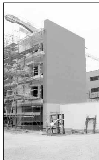
I lavori in corso (PressPhoto Lancia)
