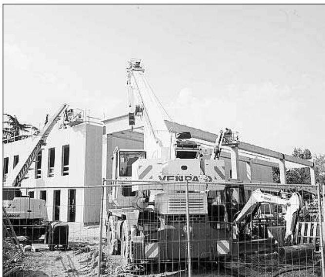
Si stanno completando i lavori di realizzazione di 12 nuove aule dell'università ai Rizzi (Foto Anteprima)
