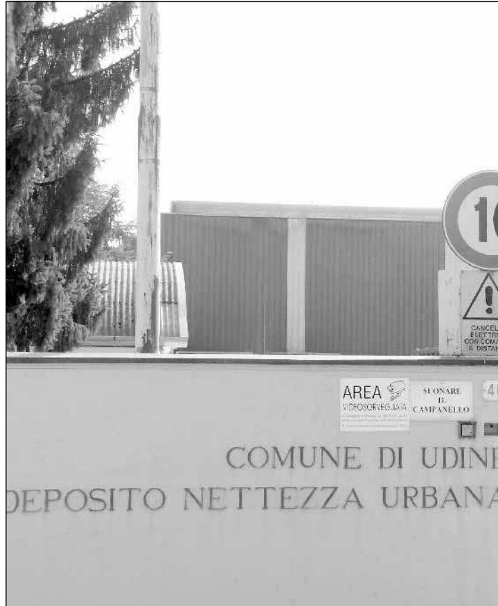
VIA GONARS L'impianto attuale di trattamento dei rifiuti
