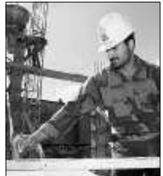
Operaio al lavoro in un cantiere
