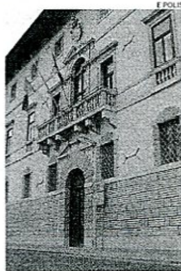
► L'ingresso di via Antonini
