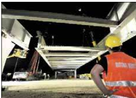
A4 L'ampliamento del tratto in Veneto
